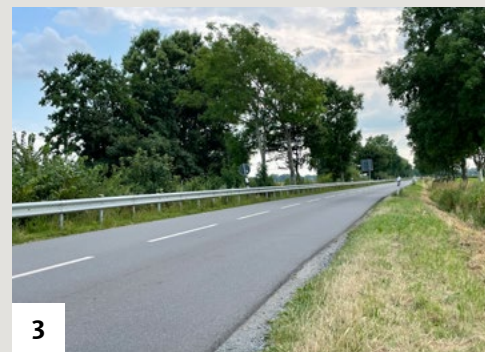
Leitplanken kanalseitig angebracht zur Stärkung der Verkehrssicherheit (K5 Richtung Lüdingworth)
